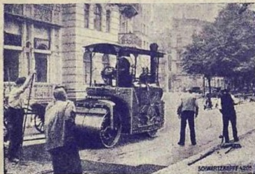
7,5-тонный каток ТЭНДЕМ, работающий с перегретым паром при укатке асфальтовой дороги
